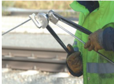
Die Elemente können vor Ort mithilfe unseres Spezialwerkzeugs angepasst werden.
