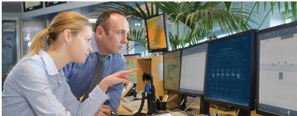
Überwachung und Steuerung des gesamten Punktheizsystems.
